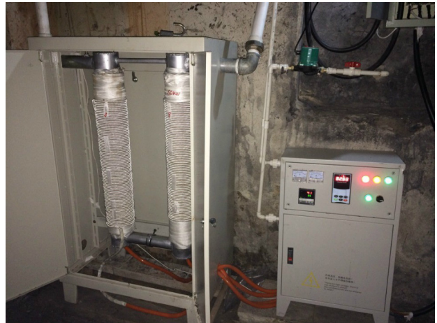
电磁加热器在采暖与热水锅炉方面的应用实例
