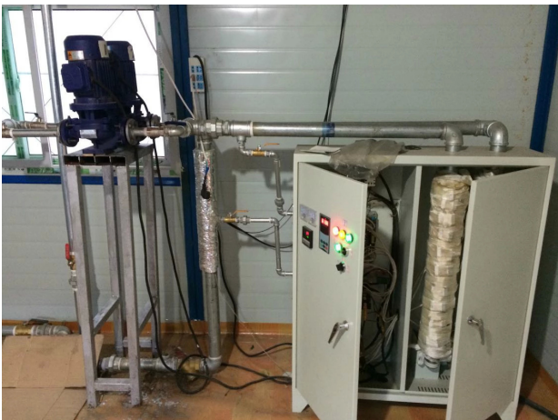
电磁加热器在采暖与热水锅炉方面的应用实例
