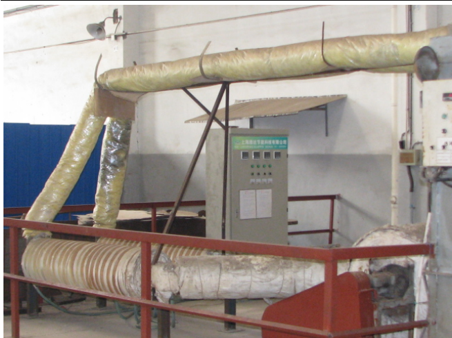
16 台全桥 30KW 在大型锅炉节能改造中的应用
